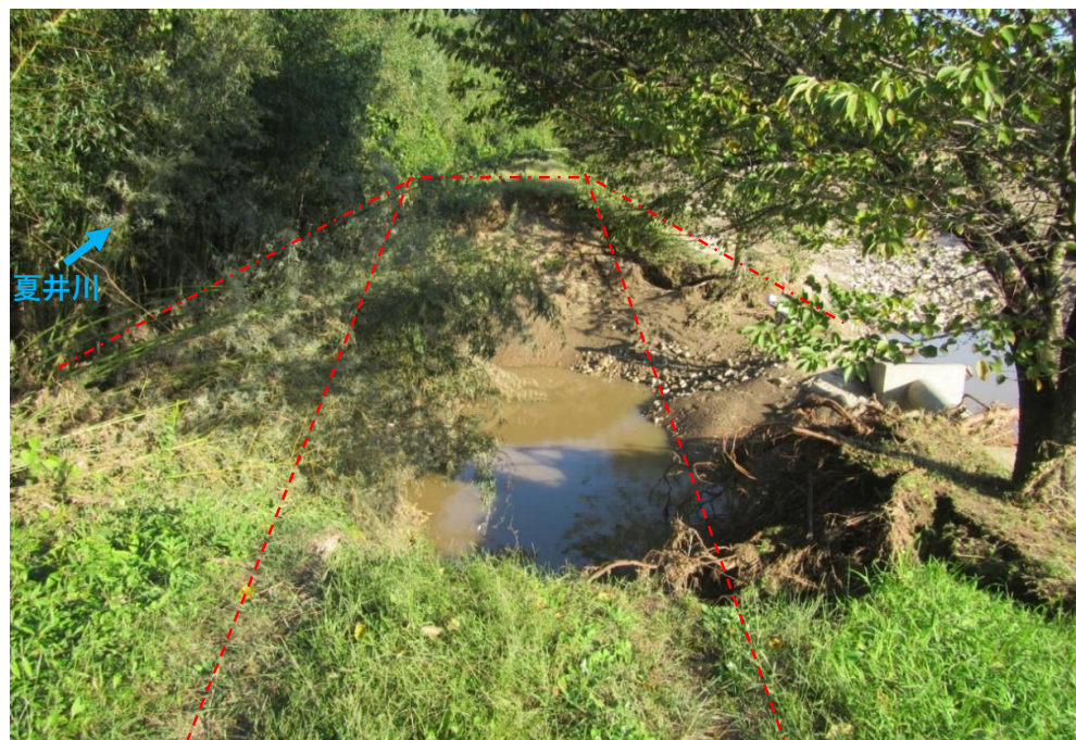
被災状況 (令和元年10月14日撮影)
