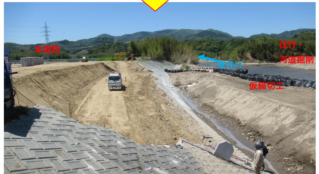
堤防盛土施工中
