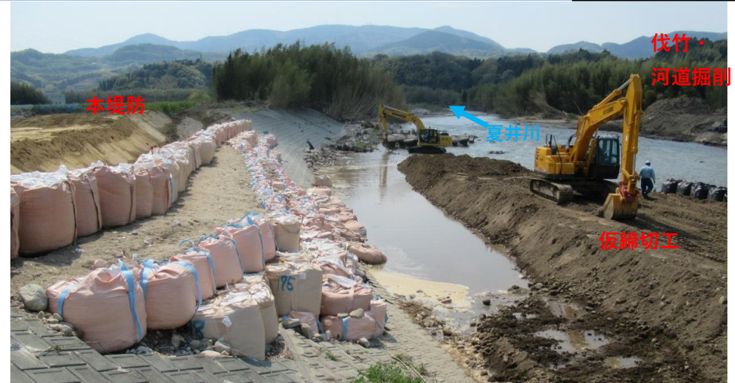
仮堤防設置完了、堤防盛土施工中
