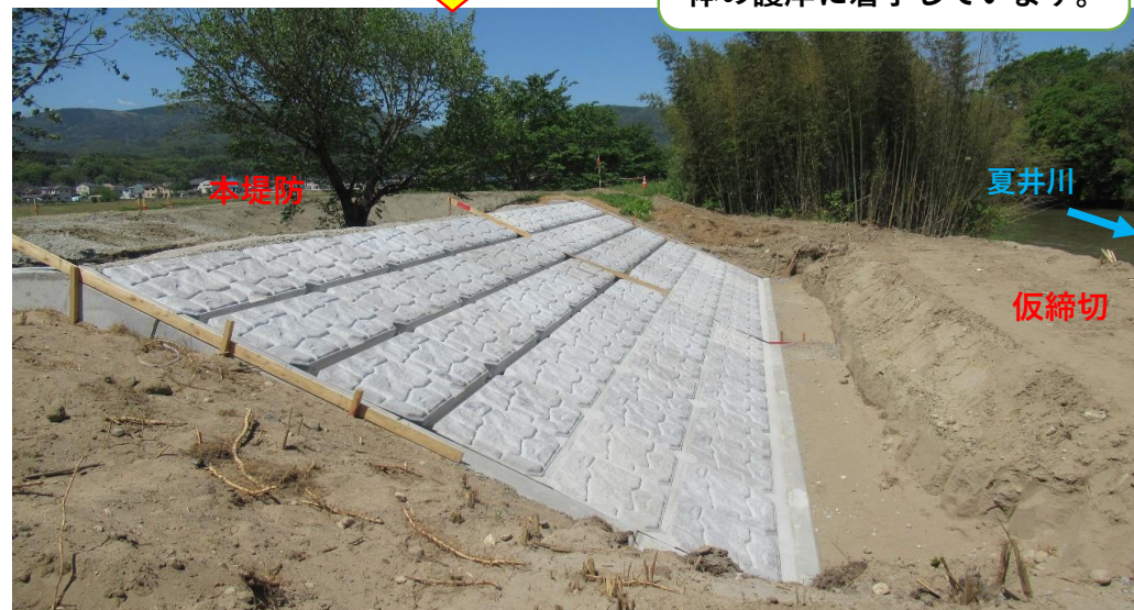
堤防護岸 コンクリート張ブロック施工中 施工状況 (令和2年5月15日)
