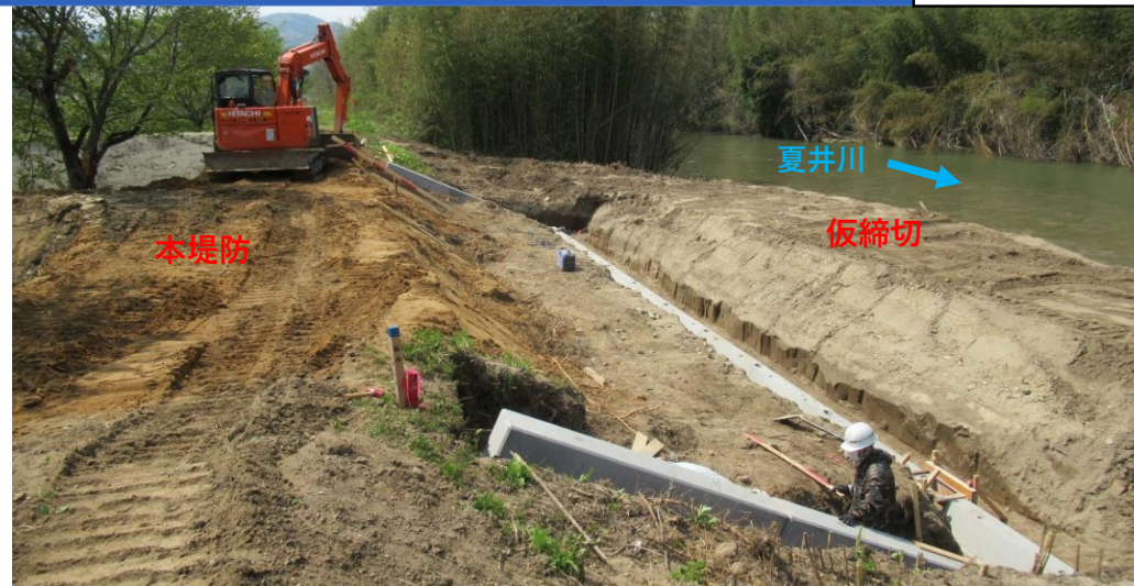
堤防護岸 コンクリート張ブロック施工中 施工状況 (令和2年4月30日)
