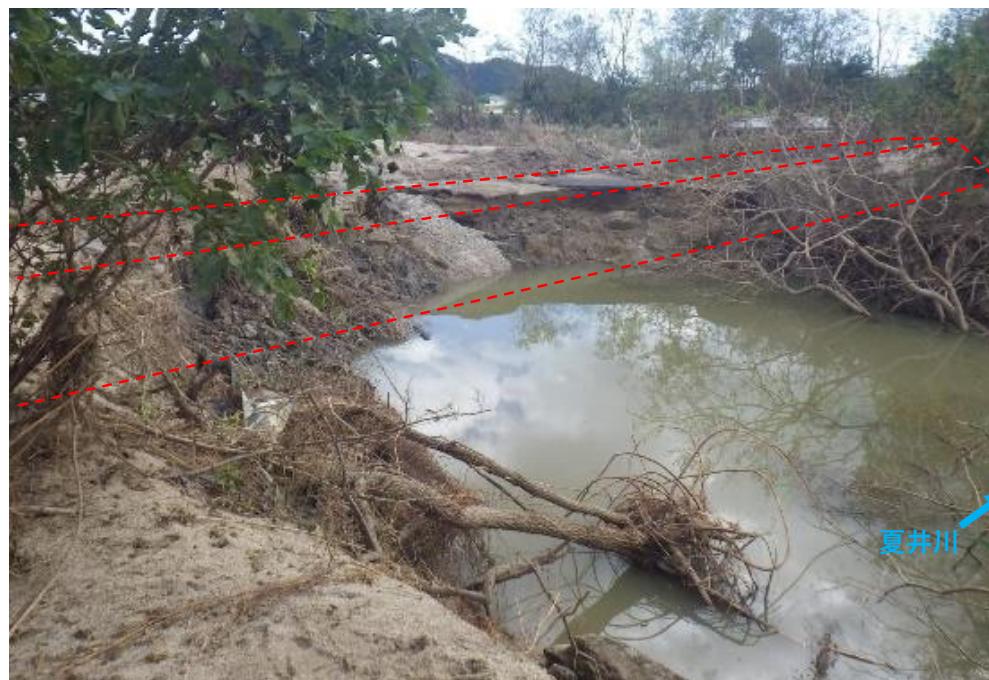
被災状況 (令和元年10月22日撮影)
