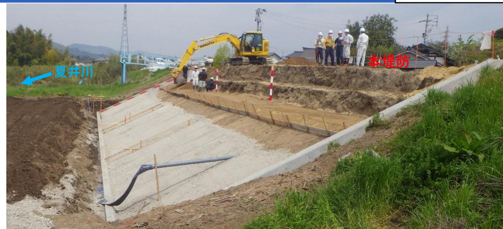
堤防護岸 コンクリート張ブロック施工中 施工状況 (令和2年4月27日)
