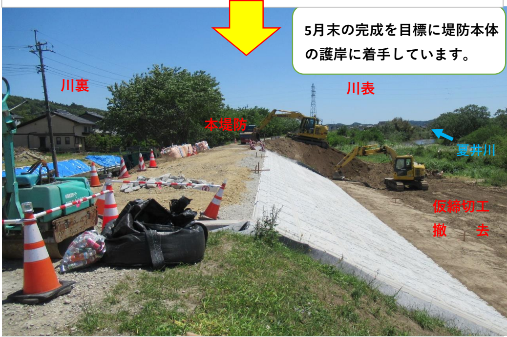
川表張りブロック完了 川裏鋼矢板打設中
