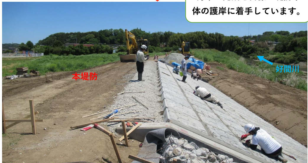
川表護岸施工中
