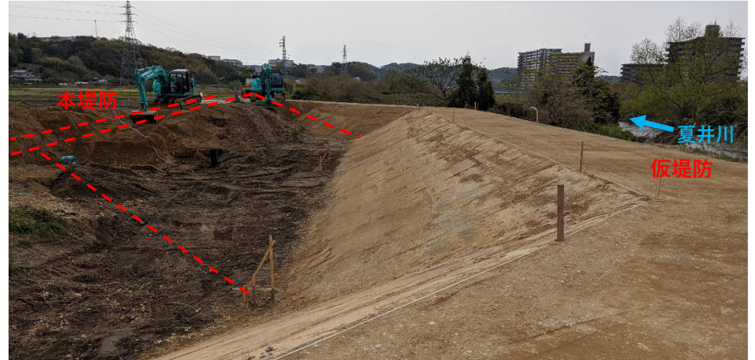
仮堤防設置完了、堤防盛土施工中
