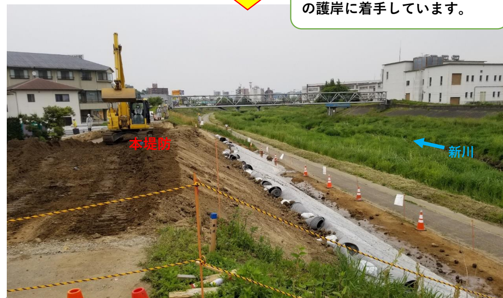
堤防盛土、張ブロック施工中
