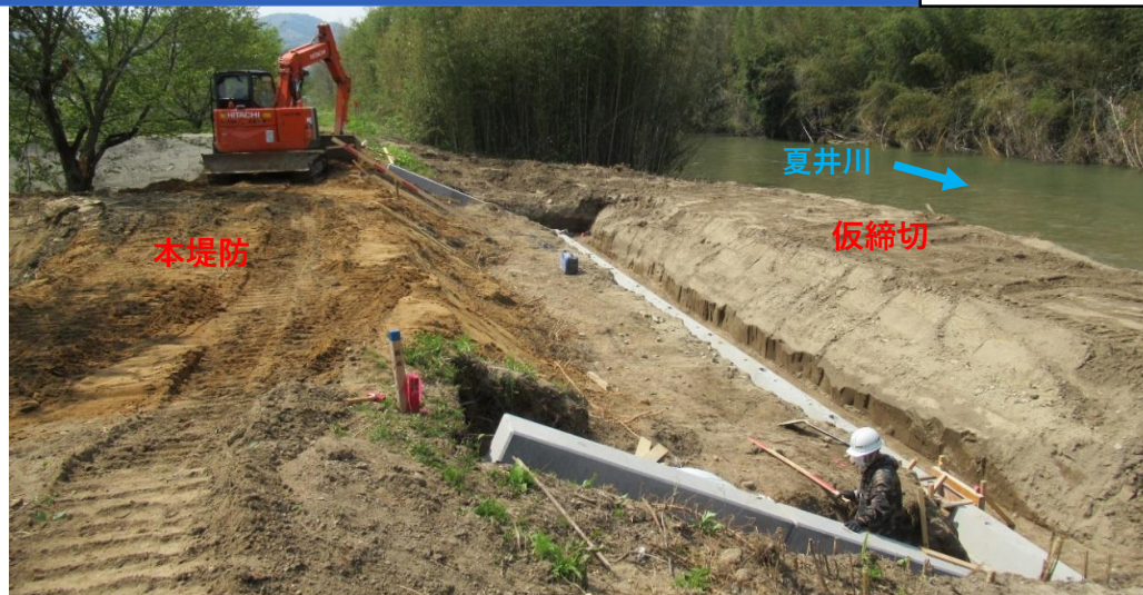
堤防護岸 コンクリート張ブロック施工中
