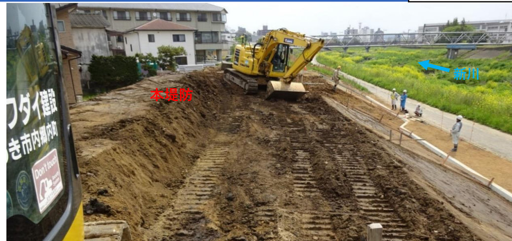
堤防盛土施工中 張ブロック施工中
