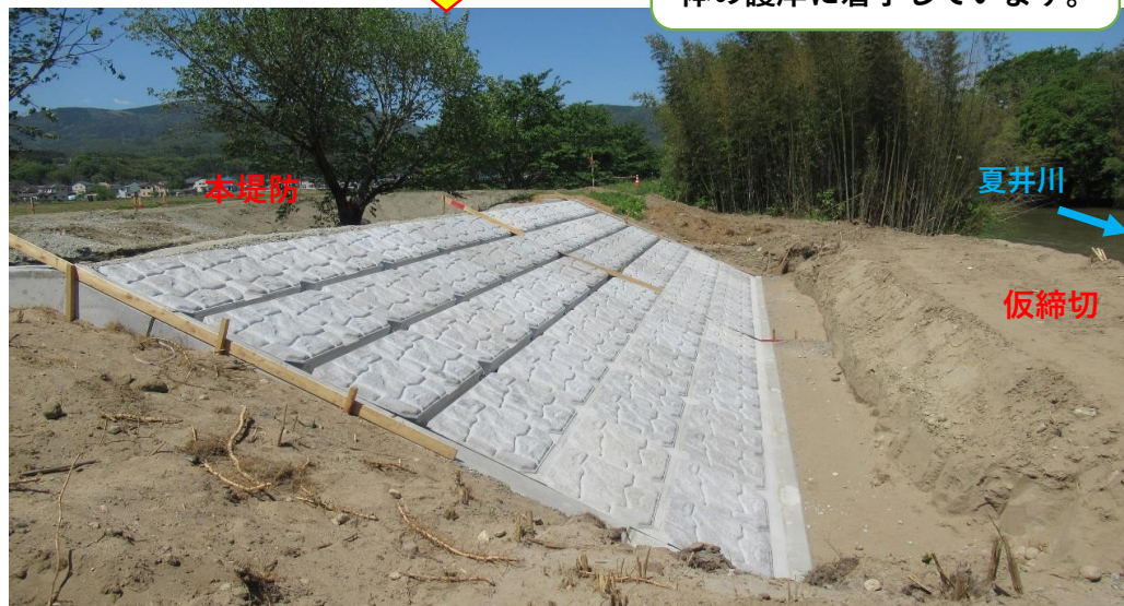
堤防護岸 コンクリート張ブロック施工中
