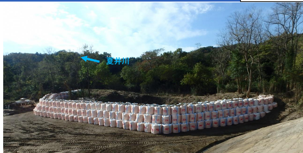
応急仮工事完了 大型土のう設置
