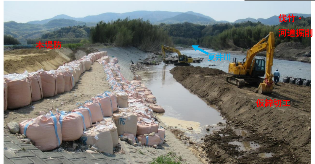
仮堤防設置完了、堤防盛土施工中
