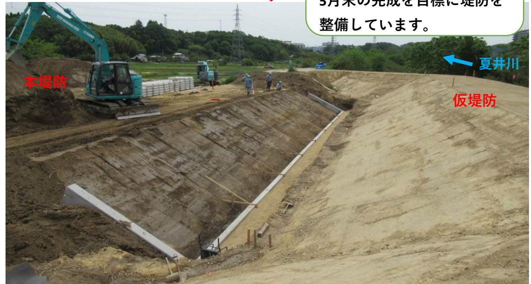
堤防盛土、小口止完了 張ブロック着手
