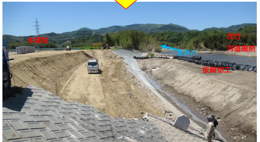
堤防盛土施工中
