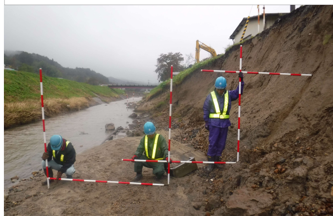
被災箇所の測量を行います
