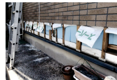
被災住宅の応急修理
