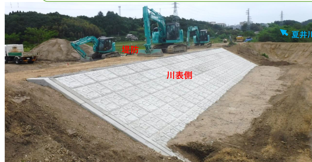
川表側 コンクリート張ブロック完了 (令和2年5月31日撮影)
