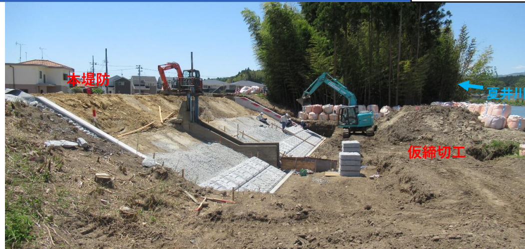
川表側 コンクリート張ブロック施工中
