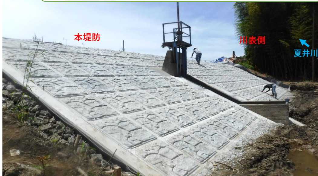
川表側 コンクリート張ブロック完了
