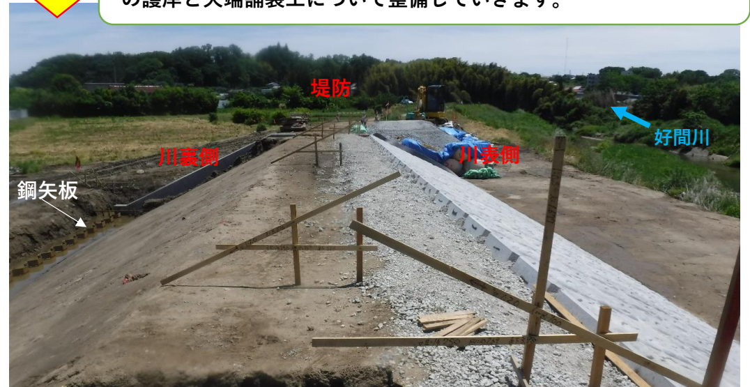
川表側 コンクリート張ブロック完了 川裏側 鋼矢板打設完了 (令和2年5月28日撮影)
