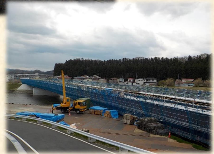
(仮称)新田町大橋
