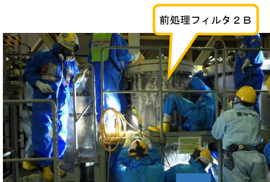
(写真1) 漏えい調査の状況
