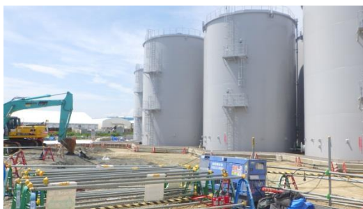
(写真2-1) エリア東側の状況①
