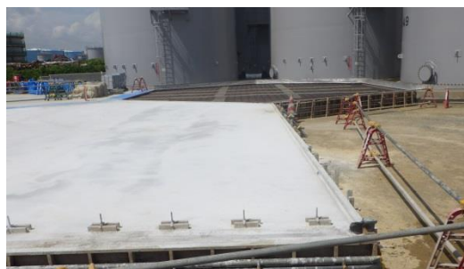
(写真2-2) エリア東側の状況②
