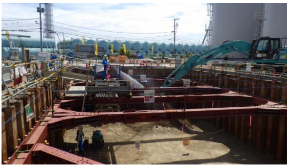
(写真1) 深層部への埋め戻し土砂投入状況 (西側から撮影)
