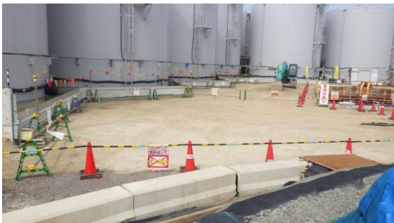
(写真2) 浅層部の状況 (南東側から撮影)
