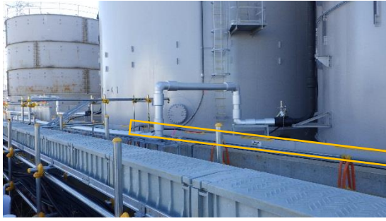
(写真3) 黄枠内が仮堰
