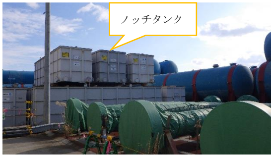
(写真3-4) 廃スラッジ一時保管施設南側
