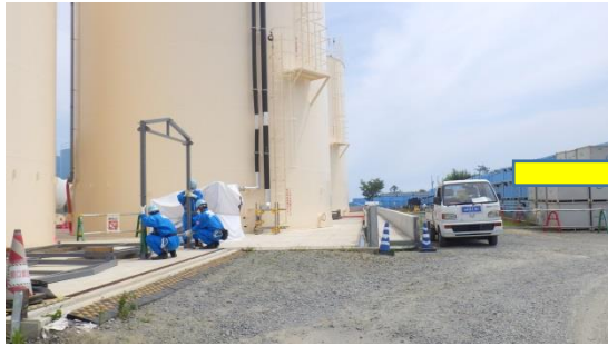
(写真 2 - 1) 前回撮影 (平成30年8月2日)
