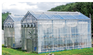
図1. 葛尾村植物工場外観 平成30年11月に2棟の植物工場の稼働を開始した。令和元年12月に断熱効果を高めた植物工場を1棟追加で設置した。
