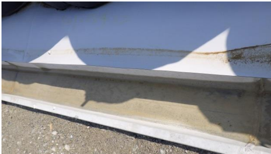
(写真 3 - 1) 養生シート周辺の側溝
