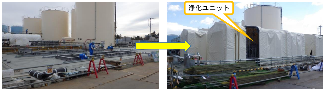
(写真1-1) 前回撮影（平成31年1月10日）
