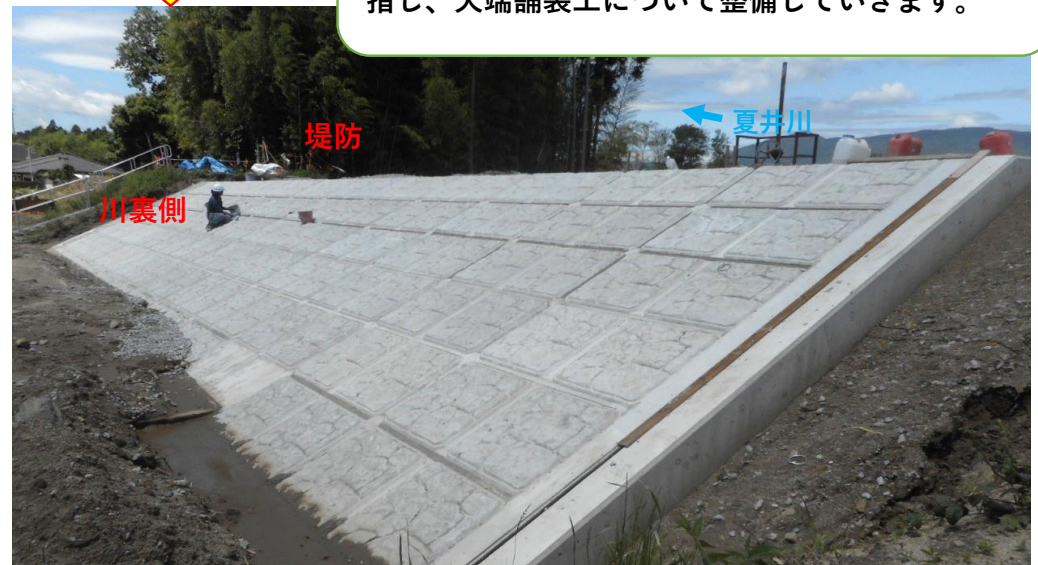
川裏側 護岸施工状況
