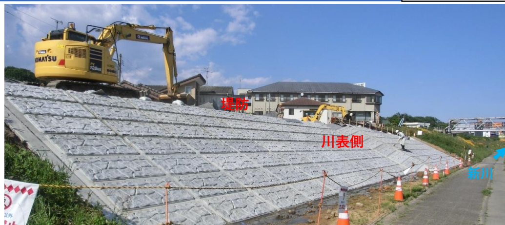
川表側 コンクリート張ブロック完了
