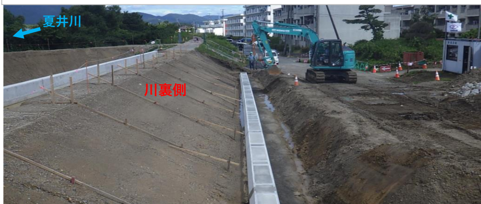
川裏側 基礎工施工状況
