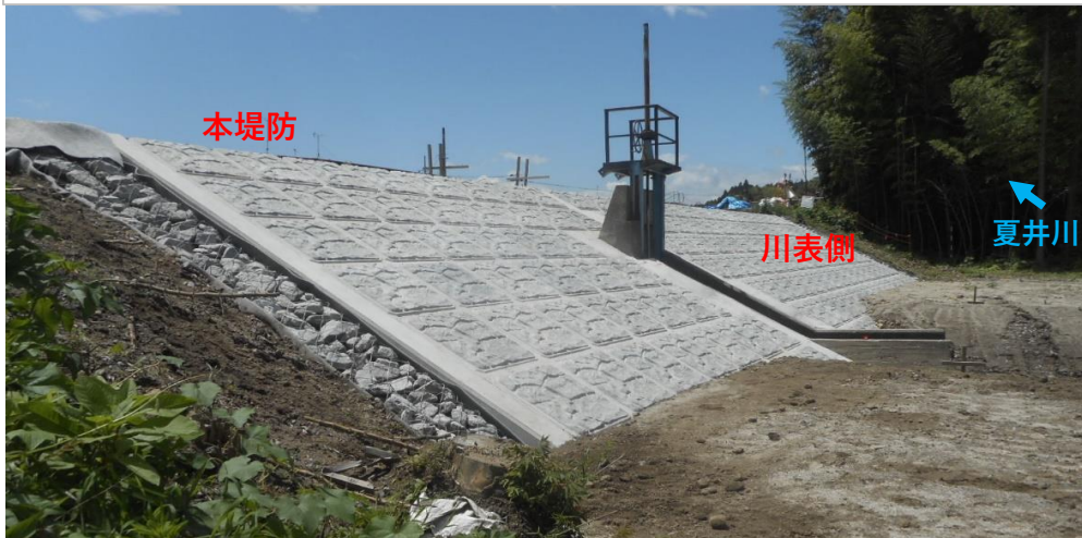
川表側 護岸工完了
