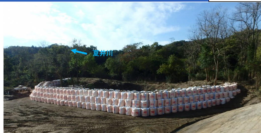
応急仮工事完了 大型土のう設置
