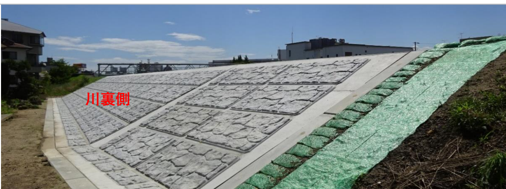
川裏側 コンクリート張ブロック完了
