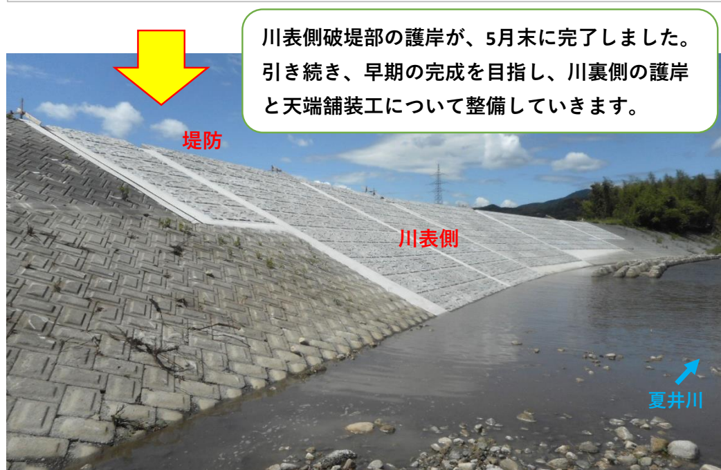
川表側 コンクリート張ブロック完了
