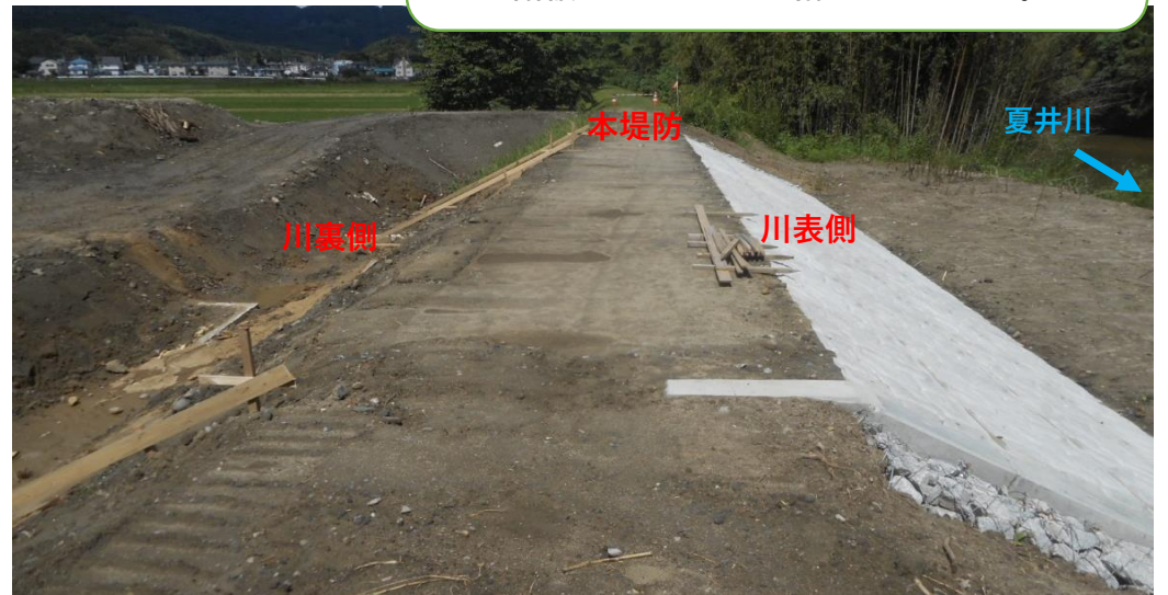
川裏側 基礎工施工状況
