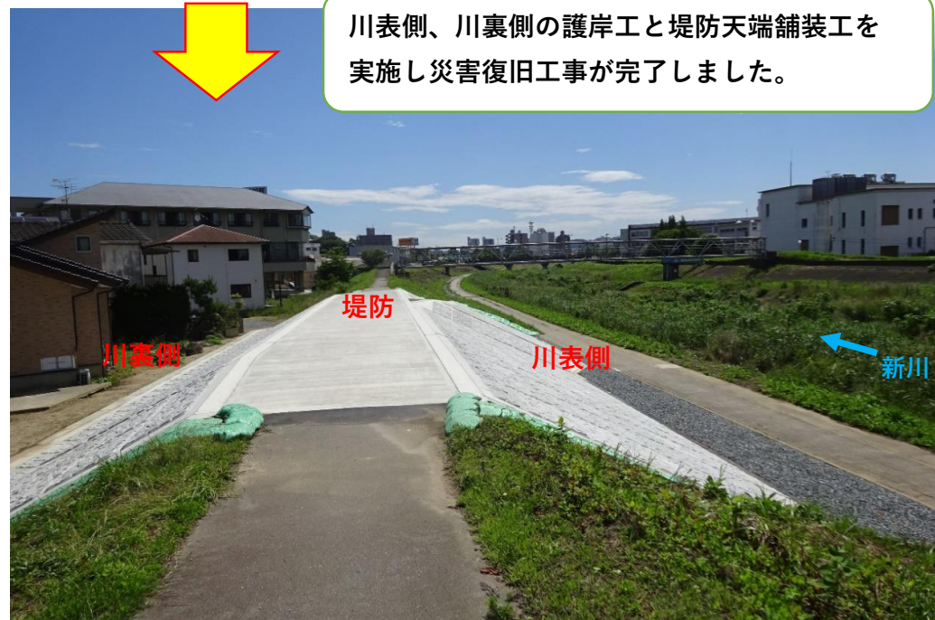
護岸工、天端舗装工完了
