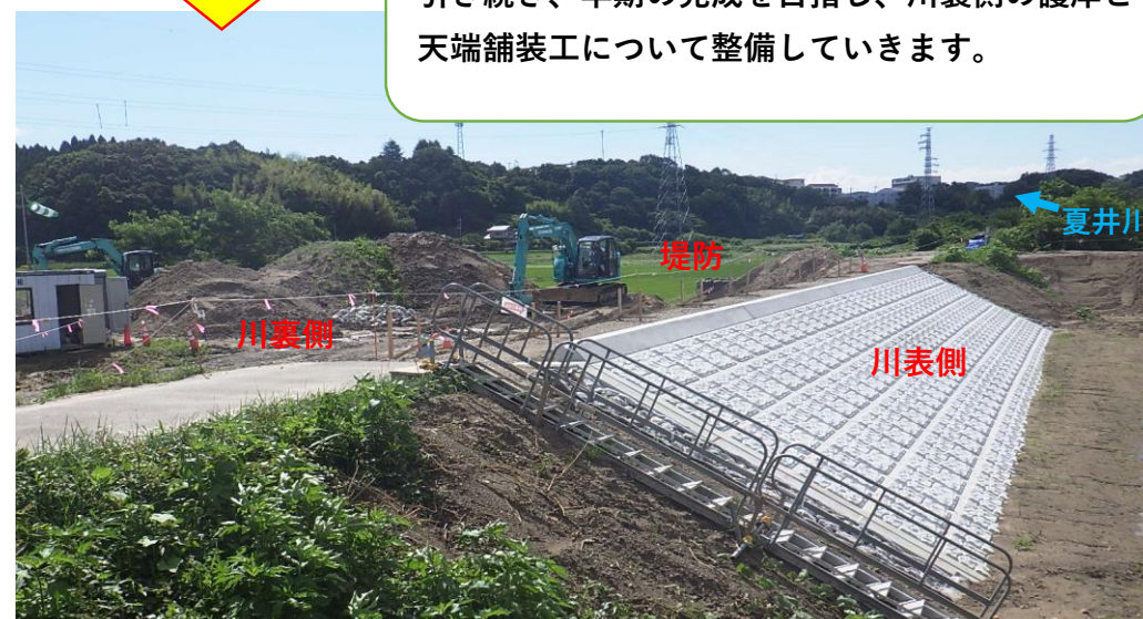
川表側 護岸工完了状況
