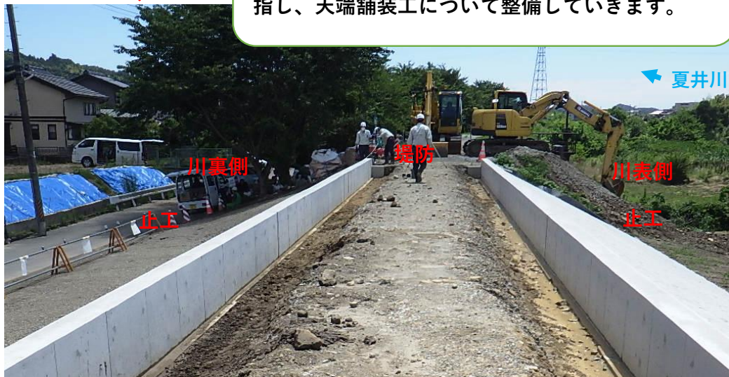
川表側、川裏側護岸工完了
