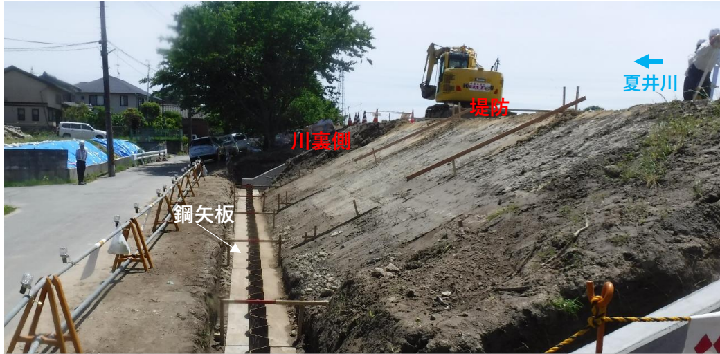
川裏側 鋼矢板打設完了
