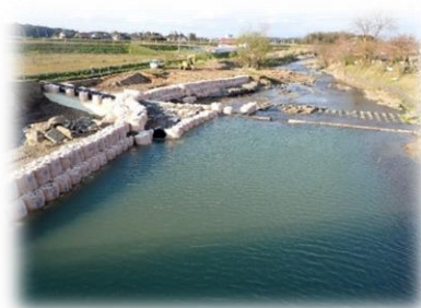
（ 仮復旧が完了し用水利用を開始 ）
