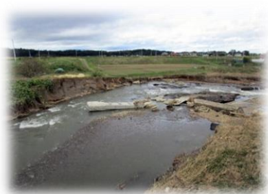
（ 台風第19号による被害状況 ）
