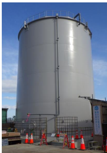
(写真1-1) 前回撮影 (平成30年12月21日)
