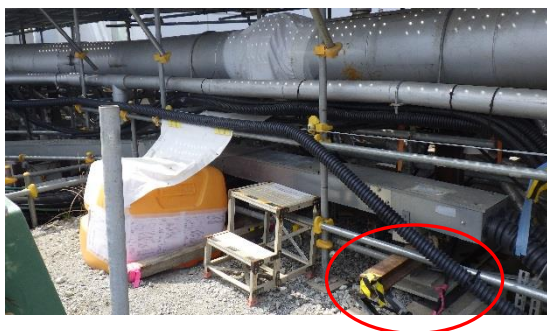
（写真1-1）6BLK-H1付近の状況。赤丸は架台高さ調整用のジャッキ。
