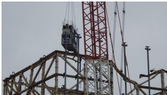
(写真2) 吸引装置
