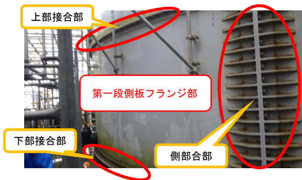
(写真 2) 第一段側板フランジ部の状況
