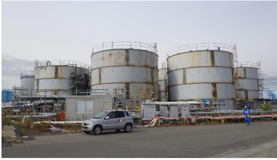
(写真1) H3タンクエリアの状況（南東側から撮影）
