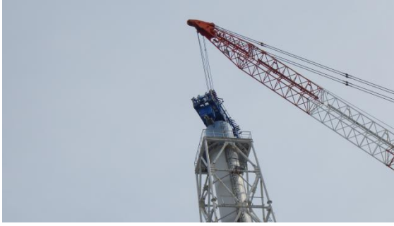
(写真7) 排気筒頂部に設置された解体装置 (筒身切断装置)
