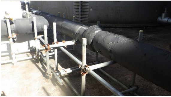
(写真4-1) 配管保温材の状況
