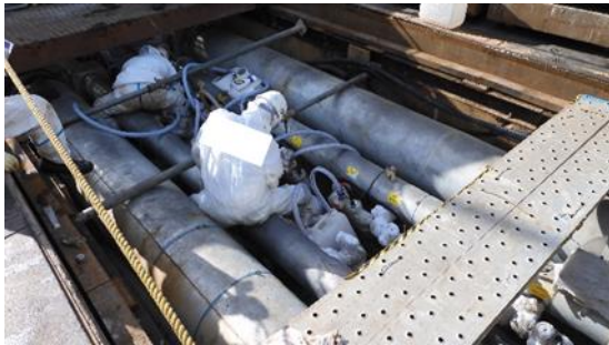
(写真5) 点検作業の状況
