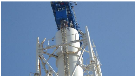
(写真5) 排気筒頂部の状況
