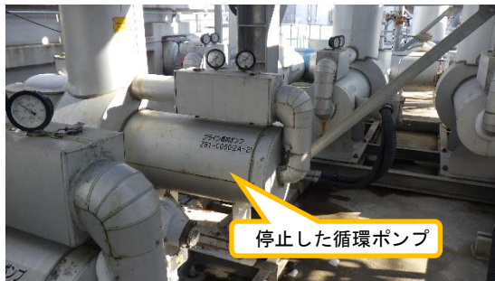
(写真4) 外観に異常は見られなかった
