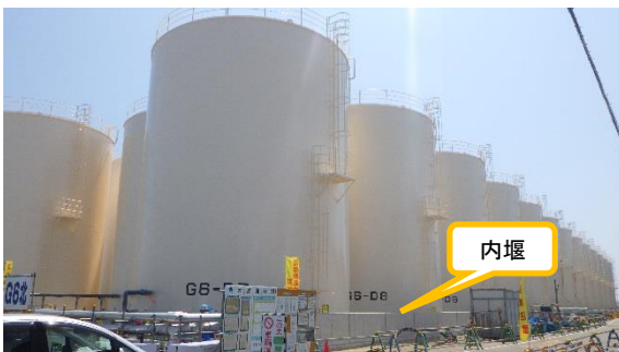
(写真1-2) G6タンクエリア外観② (北西側から撮影)
