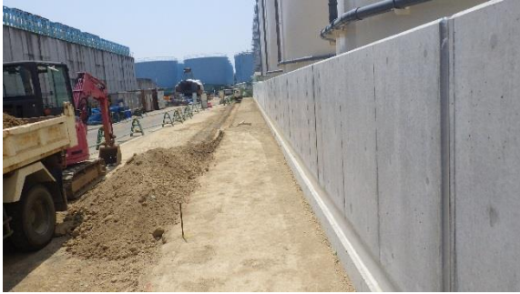
(写真 2 - 1) エリア東側の外堰床付け工事等の状況（北側から撮影）
