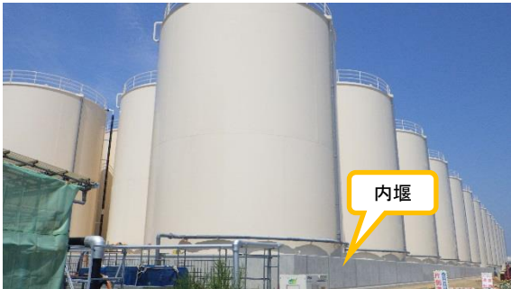
(写真1-1) G6タンクエリア外観① (南東側から撮影)
