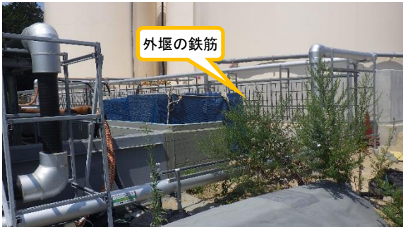
(写真 2 - 2) エリア南側の外堰鉄筋組立工事の状況（南側から撮影）
