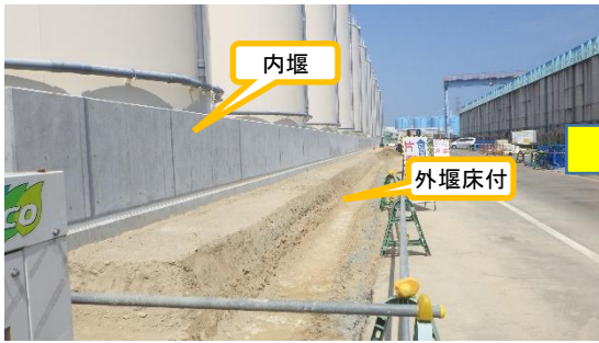
(写真3-1) エリア東側の外堰設置工事の状況 (令和元年8月19日撮影)
