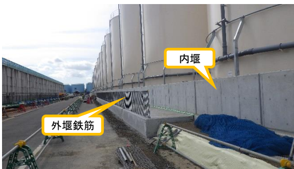
(写真3-3) エリア北東部の外堰設置工事の状況
