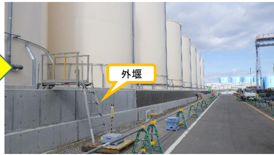
(写真3-2) エリア東側の外堰設置工事の状況 (本日(令和2年2月19日)撮影)
