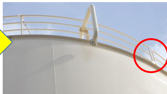
(写真5-2) 天板手摺り補修状況 (本日(令和2年2月19日)撮影)
