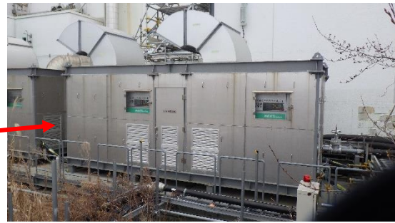
(写真1-2) 空気圧縮機の設置状況②
