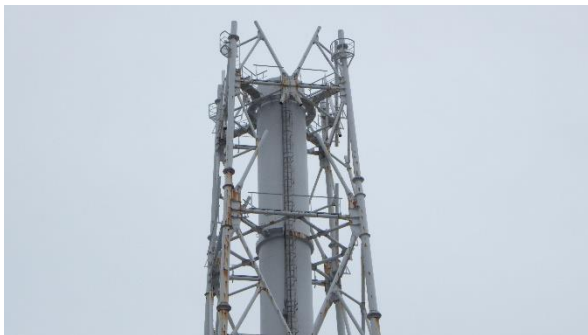
(写真2-1) 13ブロック(筒身)解体後の排気筒の状況 (1 / 2号機開閉所前から撮影)
