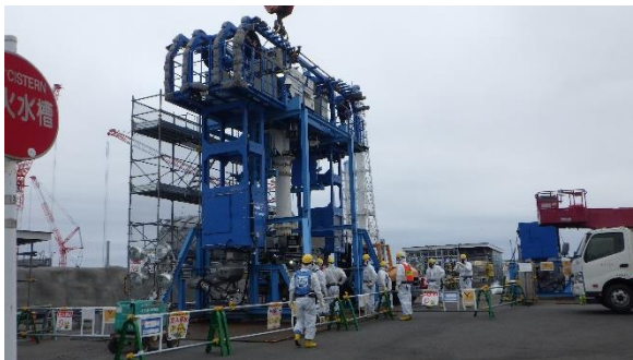
(写真2-2) 筒身解体装置の点検の状況 (1 / 2号機開閉所前南側)
