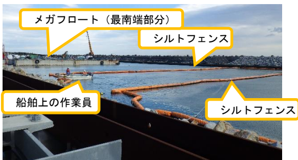
(写真2-1) シルトフェンスの状況
