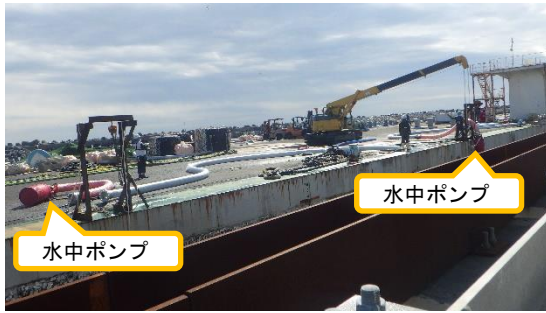
(写真3) メガフロート上の作業の状況
