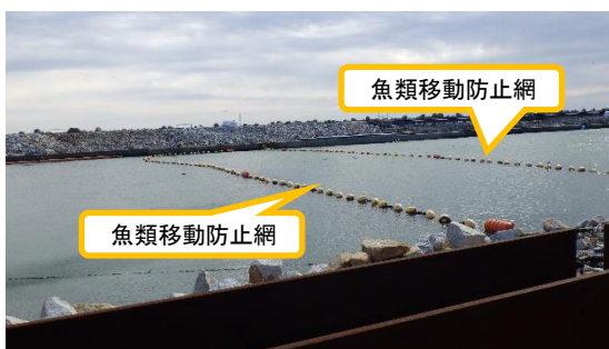
(写真2-2) 魚類移動防止網の状況 写真2-1の南側を撮影
