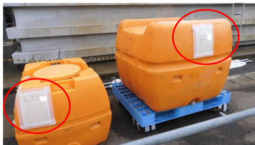
(写真2-1) ローリータンクに漏えい防止のための記録用紙が貼付されている。
