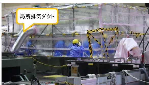
(写真1-1) 汚染拡散防止ハウスの状況①
