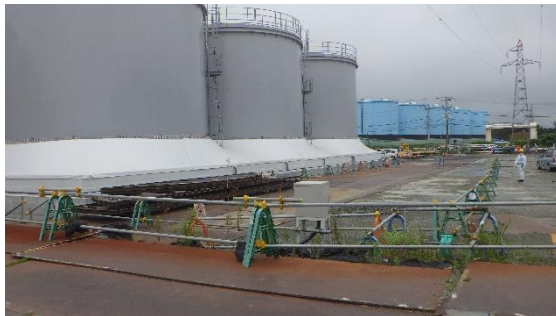
(写真 3 - 2) 屋外一時保管場所 (H5 タンクエリ ア東側)
