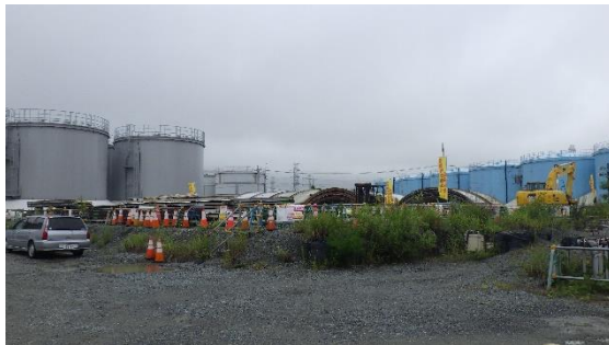
(写真 3 - 1) 屋外一時保管場所 (H5 タンクエ リア北側)
