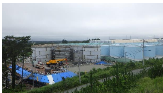
(写真1-2) 今回の状況 (令和2年7月29日) 手前の3基が撤去
