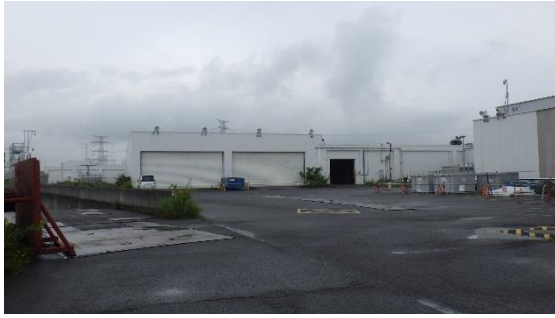
(写真1) 固体廃棄物貯蔵庫（東側から撮影） 正面に見えるのは第4棟。 第6棟～第8棟は、この裏側に位置する。
