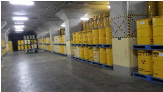
(写真2) 廃棄物貯蔵状況 廃棄物入りのドラム缶が最大3段で 保管（地下2階）
