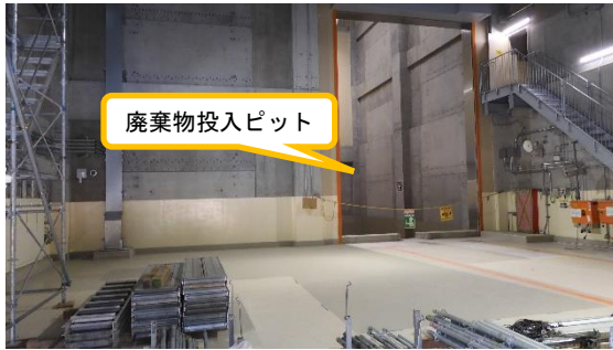
(写真 2 - 3) 廃棄物搬入口内部の状況
