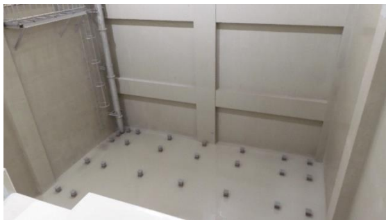
(写真 2 - 4) 投入ピット内部の状況 ピット下部にはステンレス製のすのこを敷き、廃棄物が直に床面に触れないようにするとのこと
