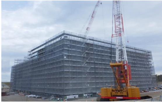
(写真1-1) 建屋の状況 前回(平成30年12月26日)撮影 (南東側から撮影)
