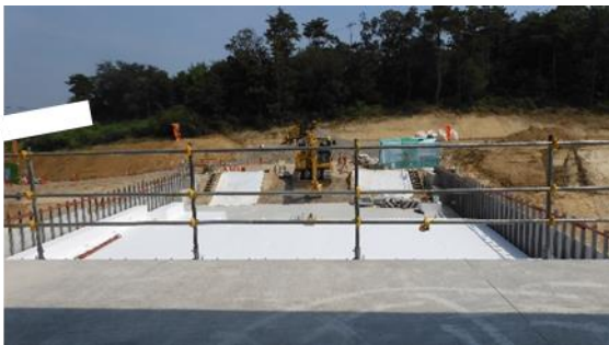
(写真2-2) 建設中の栈橋拡大(写真2-1赤丸部分拡大)
