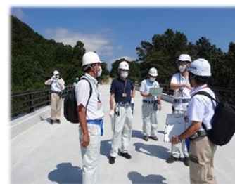
〔広域農道「いわき地区」 加路川大橋工事現場〕
