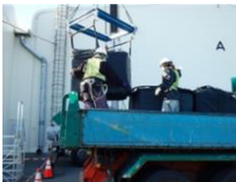
輸送車両への廃棄物積込状況
