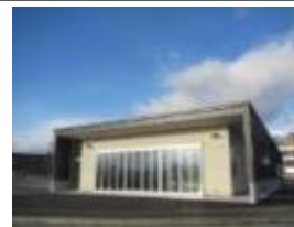
猪苗代水環境センター
