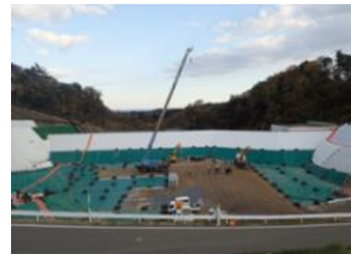
埋立処分施設の状況
