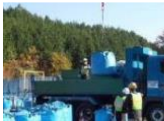
除去土壌等の車両積込状況
