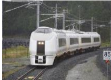
竜田～富岡駅間を走行する常磐線
