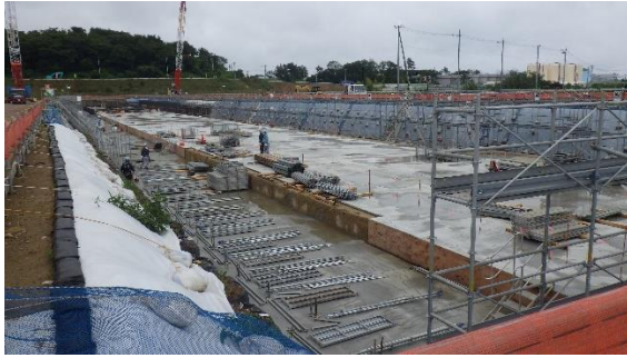
(写真1-1) 南西側から撮影 (前回撮影：令和2年6月23日) ※写真奥側が1工区、手前側が3工区
