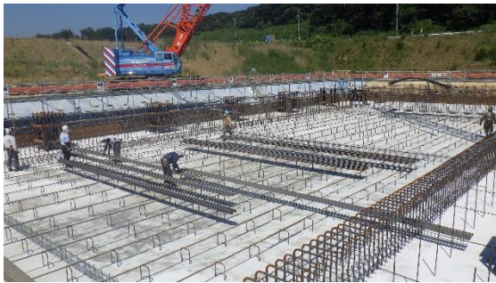
(写真1-4) 第1工区の作業状況（鉄筋組立て作 業）
