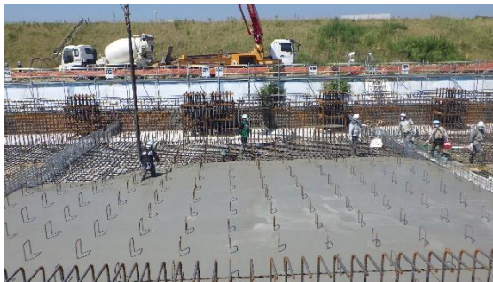
(写真1-3) 第2工区の作業状況（コンクリート 打設作業）
