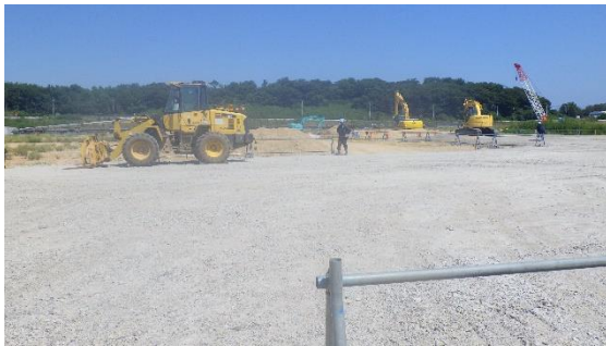
(写真3) 搬入路の整備状況 砕石が敷き均されている
