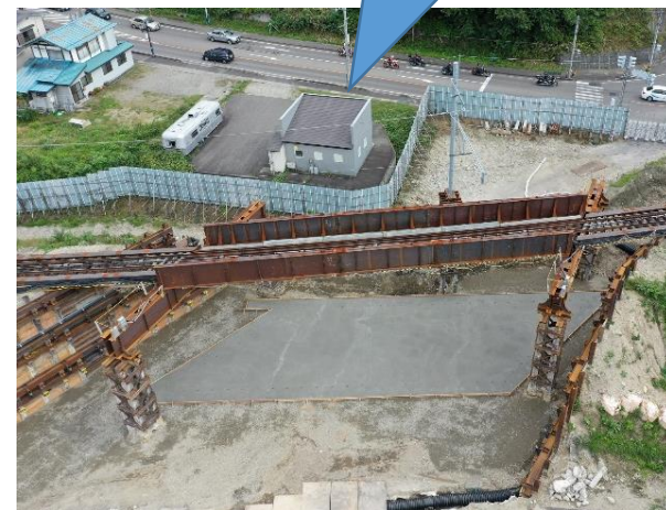
南会津町田島地内
