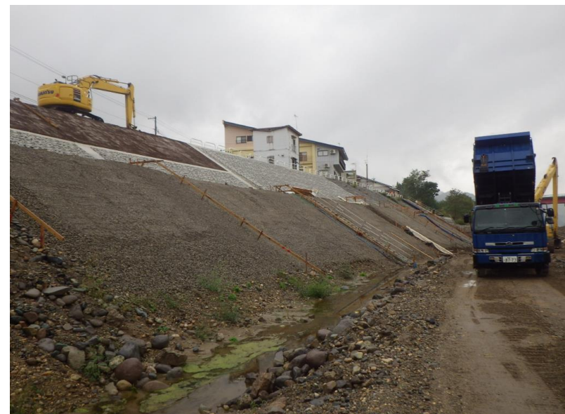
施工状況（令和2年10月5日撮影）
