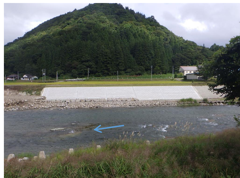
令和2年度9月14日に工事が完了しました
