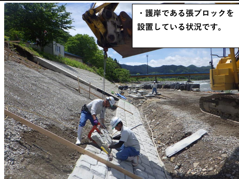
施工状況（令和2年5月27日撮影）
