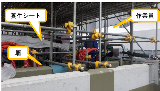
(写真2) 堰内の養生シート補修作業の状況
