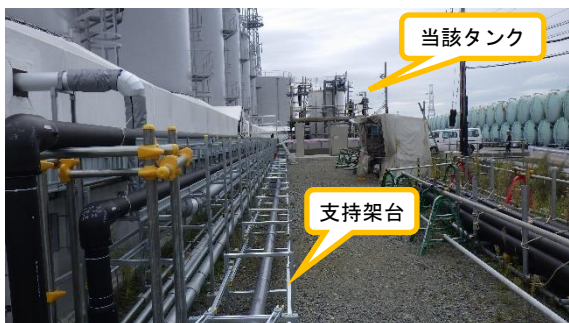
(写真3-3) 雨水排水管の敷設状況
