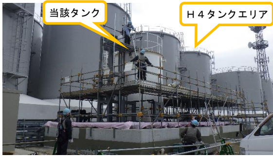
(写真1) 増設RO濃縮水受タンクの概況 (足場を組む作業が行われていた。)
