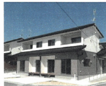
下北道団地(広野町)ふくしま復興ステーション *****
