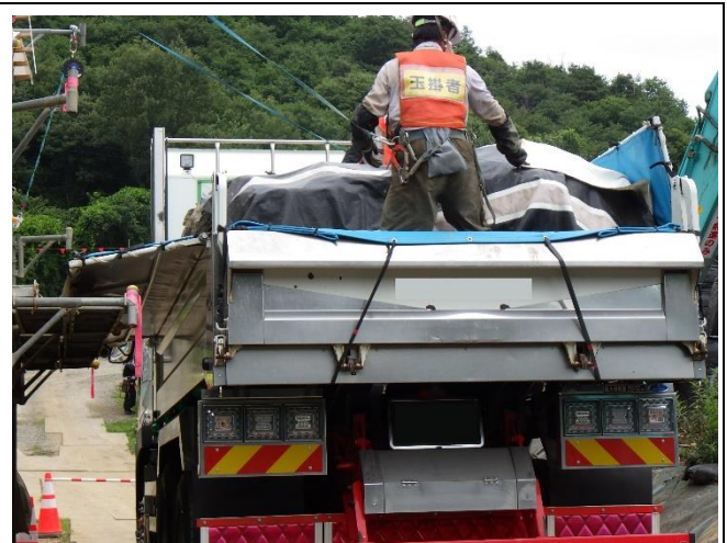
シートによる飛散・流出防止対策
