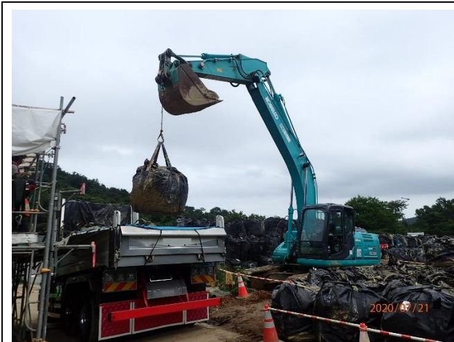
除去土壌等の積込作業
