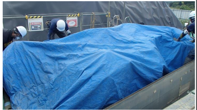
シートによる飛散・流出防止対策
