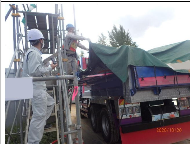
シートによる飛散・流出防止対策
