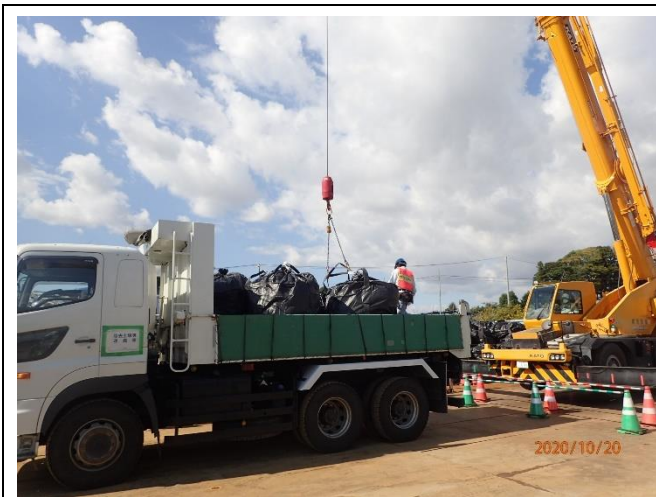
除去土壌等の積込作業
